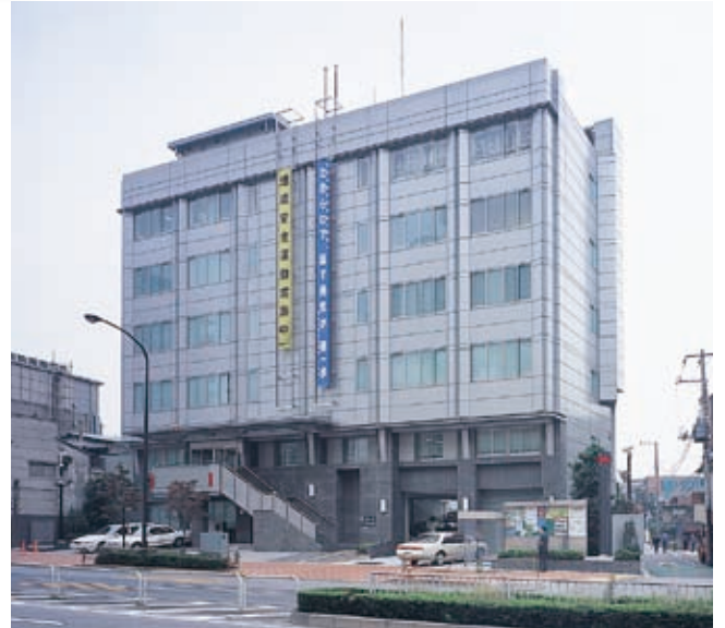
警視庁富坂警察署庁舎 [改装後]
